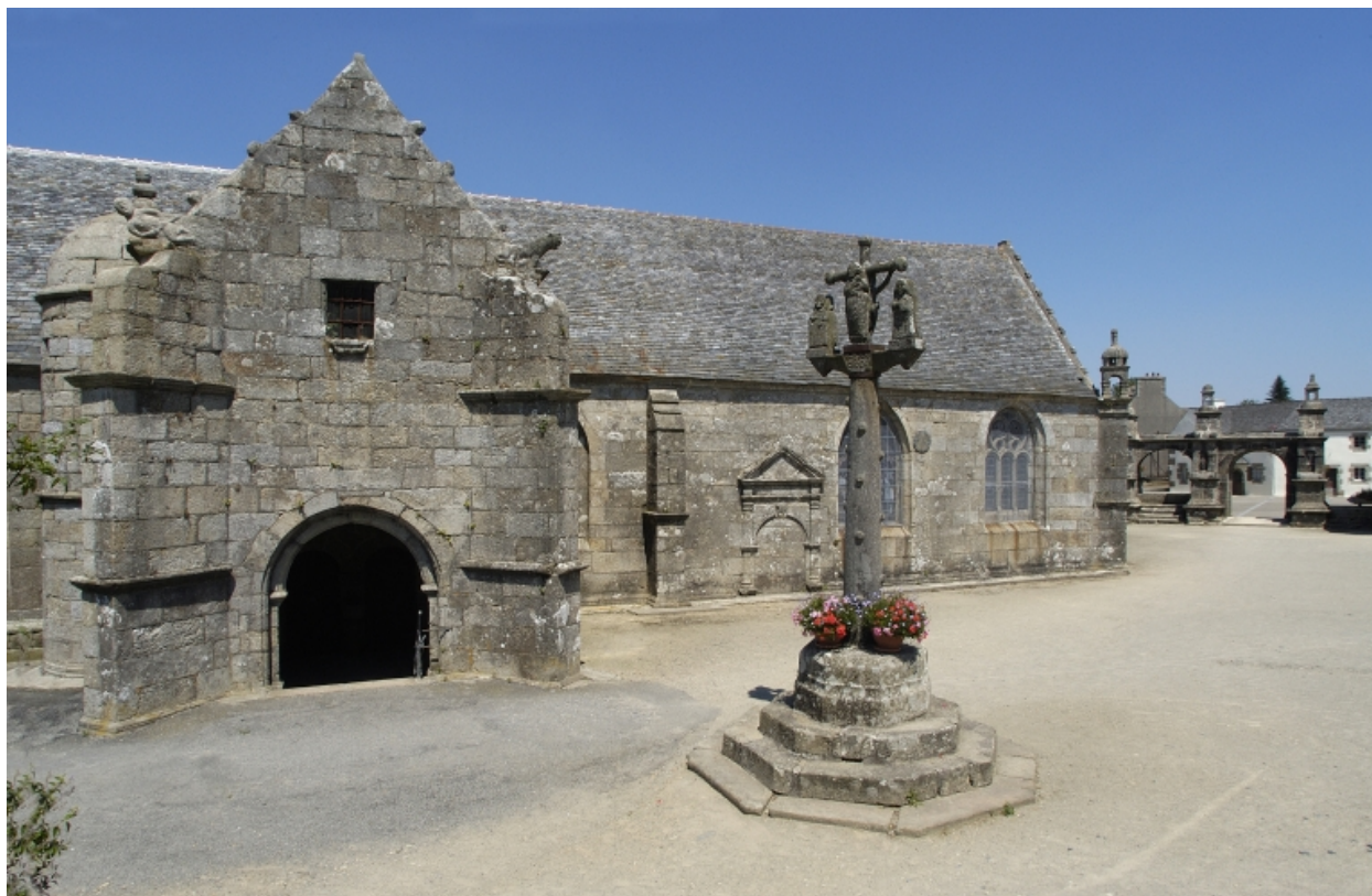
Porche sud et partie est du bas-côté sud
