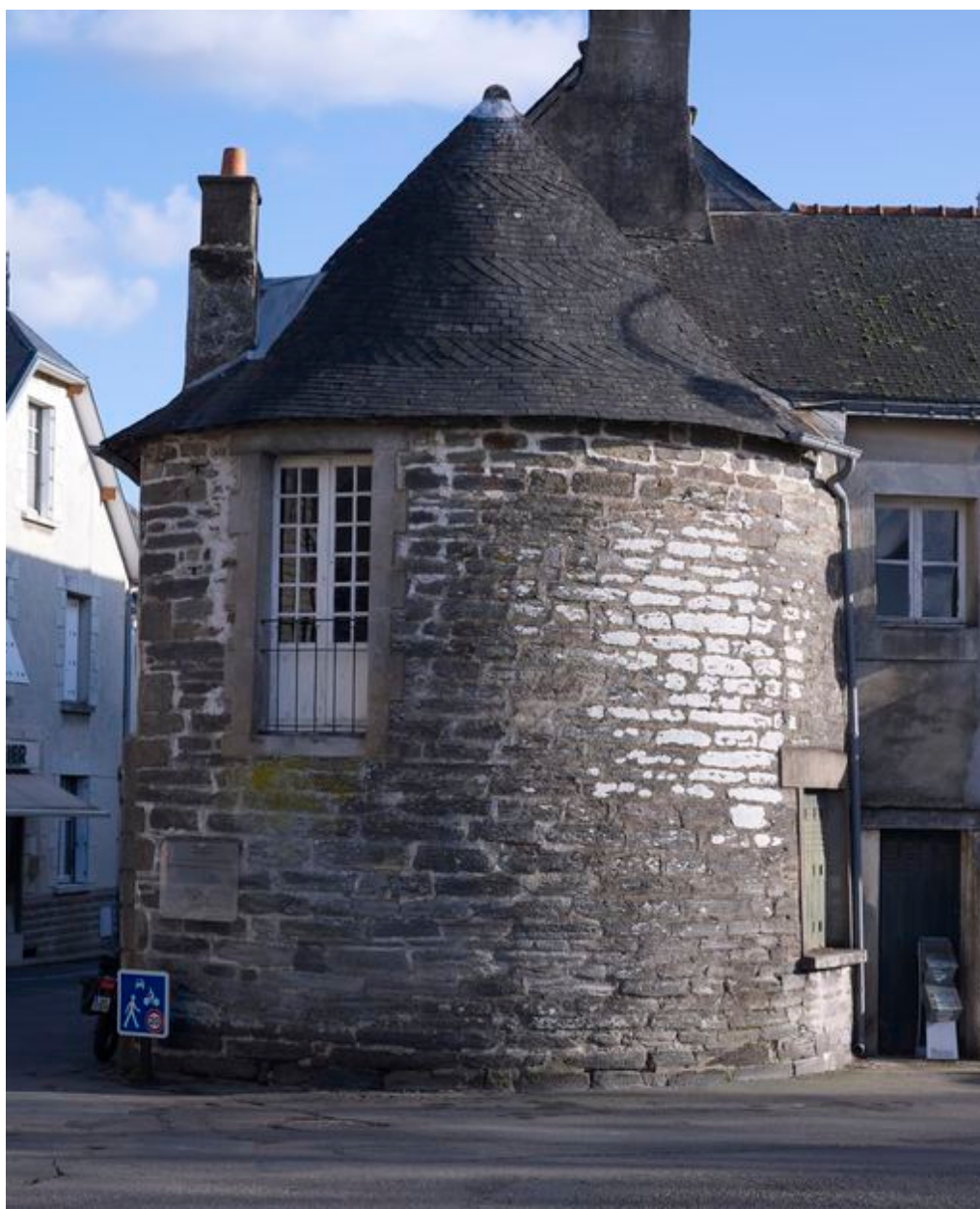
13, rue Saint-Michel : ancienne porte de la ville, vue de l'ouest (état en 2012)
