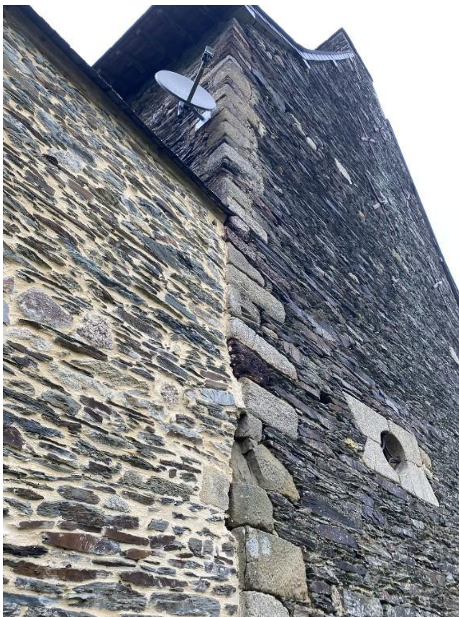
Chaînage d'angle, pignon sud
