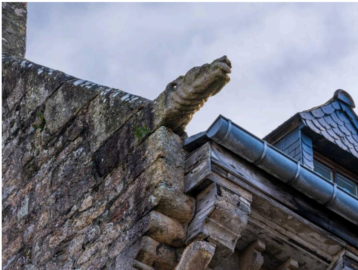
Gargouille en pierre au-dessus d'un ressaut du pignon nord.
