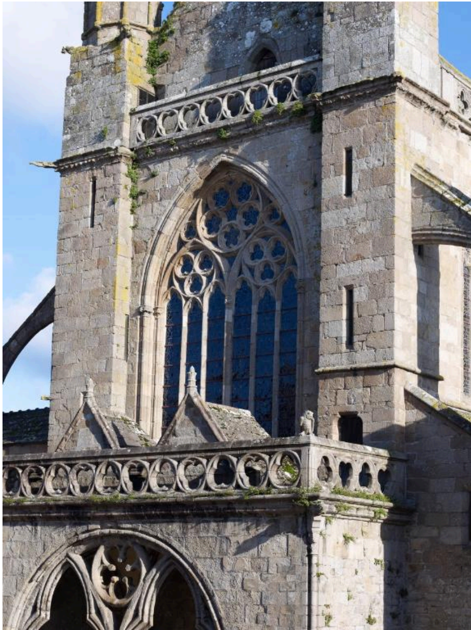
Détail de la façade occidentale
