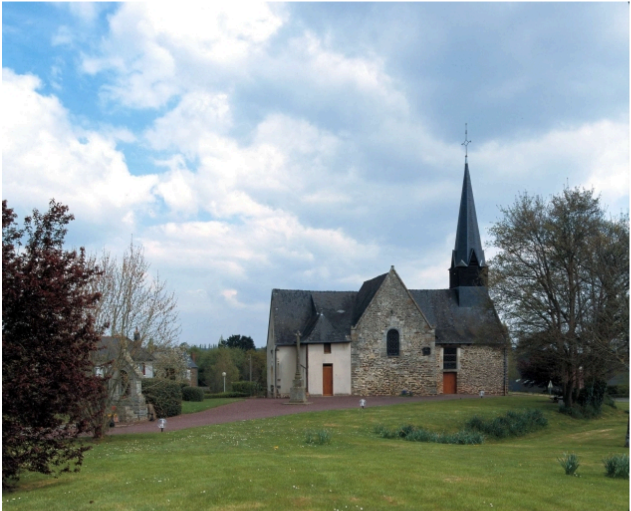
Façade nord, état après restauration
