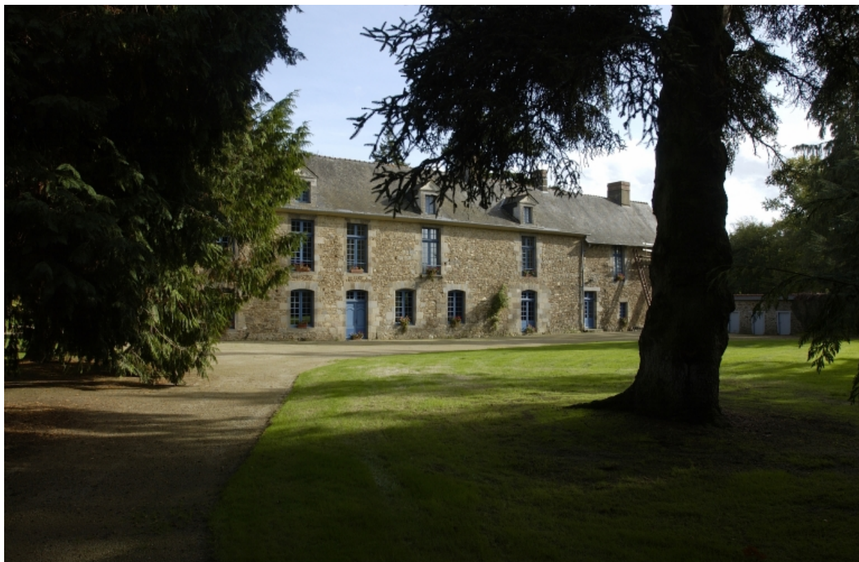
Vue générale : façade ouest
