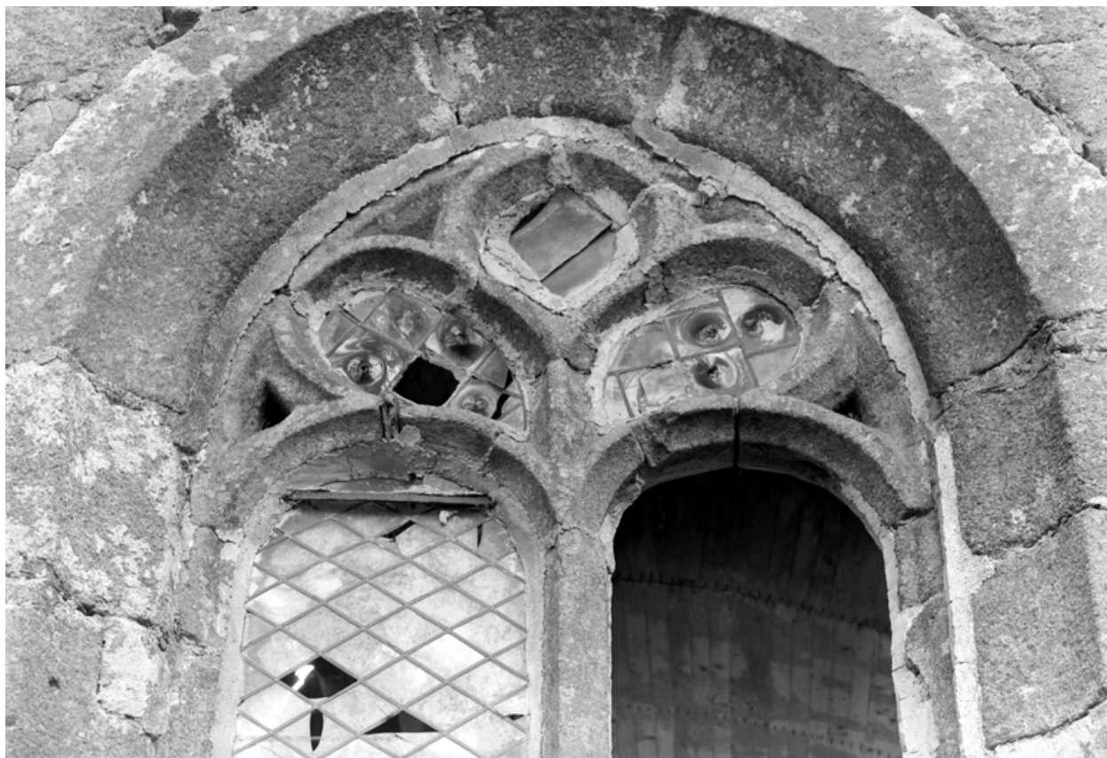
Mur nord du bras nord du transept : détail du réseau de la fenêtre
