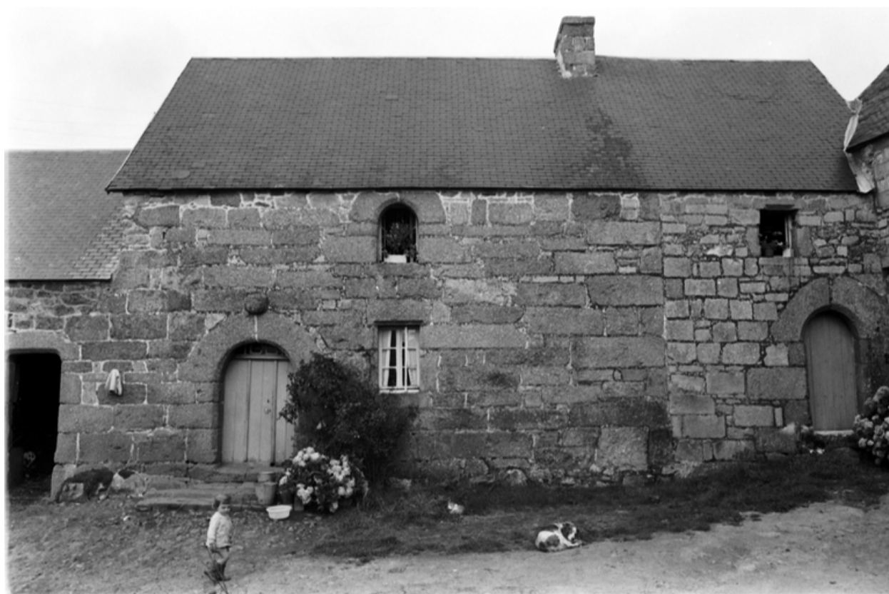
Maison (Le Cosquer) : bâtiment A, vue de la face sud
