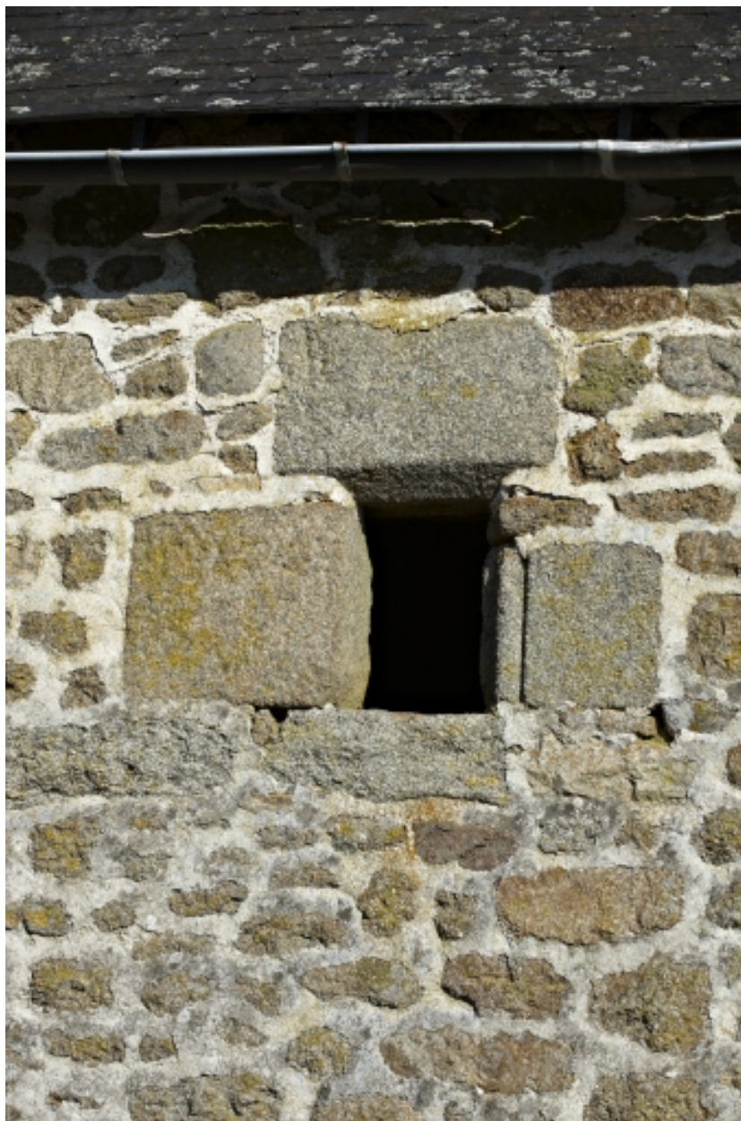
Métairie, fenêtre de l'étage.
