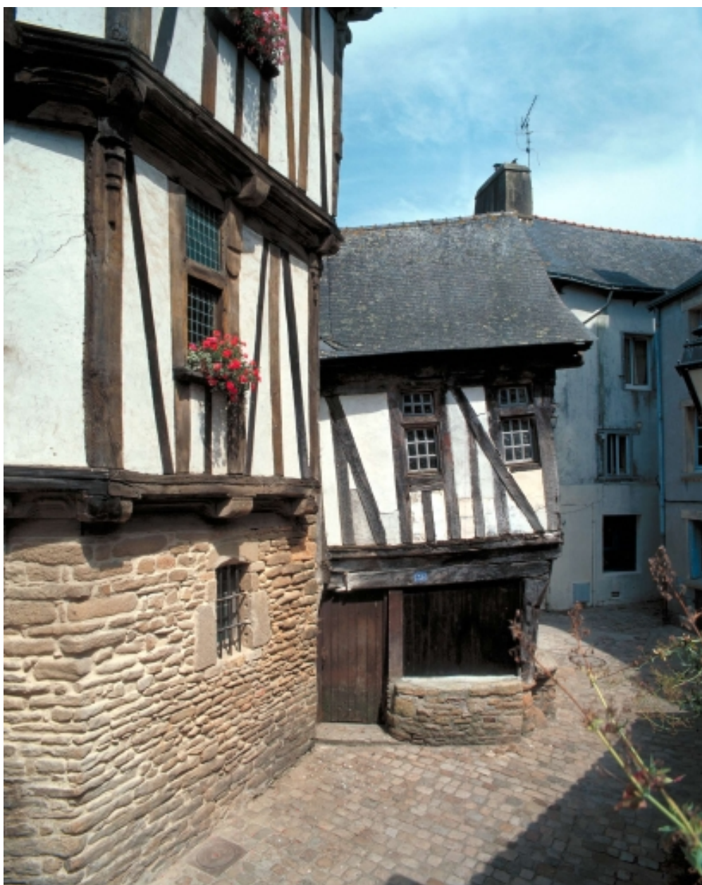
Elévation sud, vue générale
