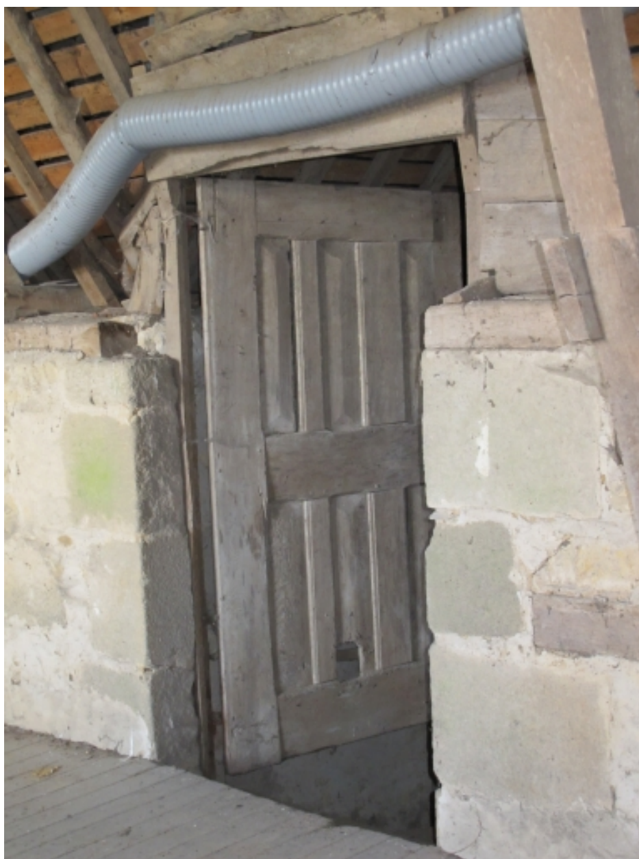
Porte d'accès aux combles du pavillon du logis
