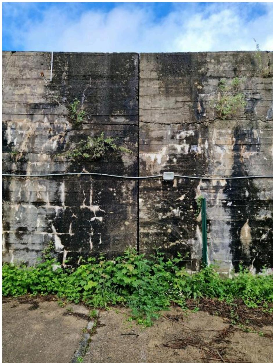
Vue de détail de l'élévation est. Le bunker a été construit en plusieurs tronçons reliés par des joints de dilatation (disparus). Autour du bunker se trouve une vaste aire bétonnée
