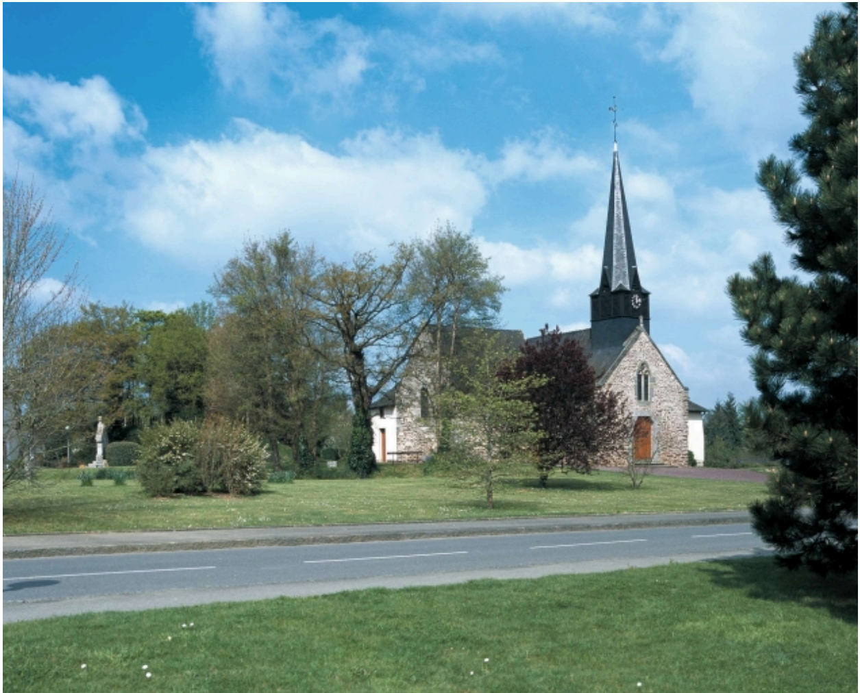
Elevation est, état après restauration
