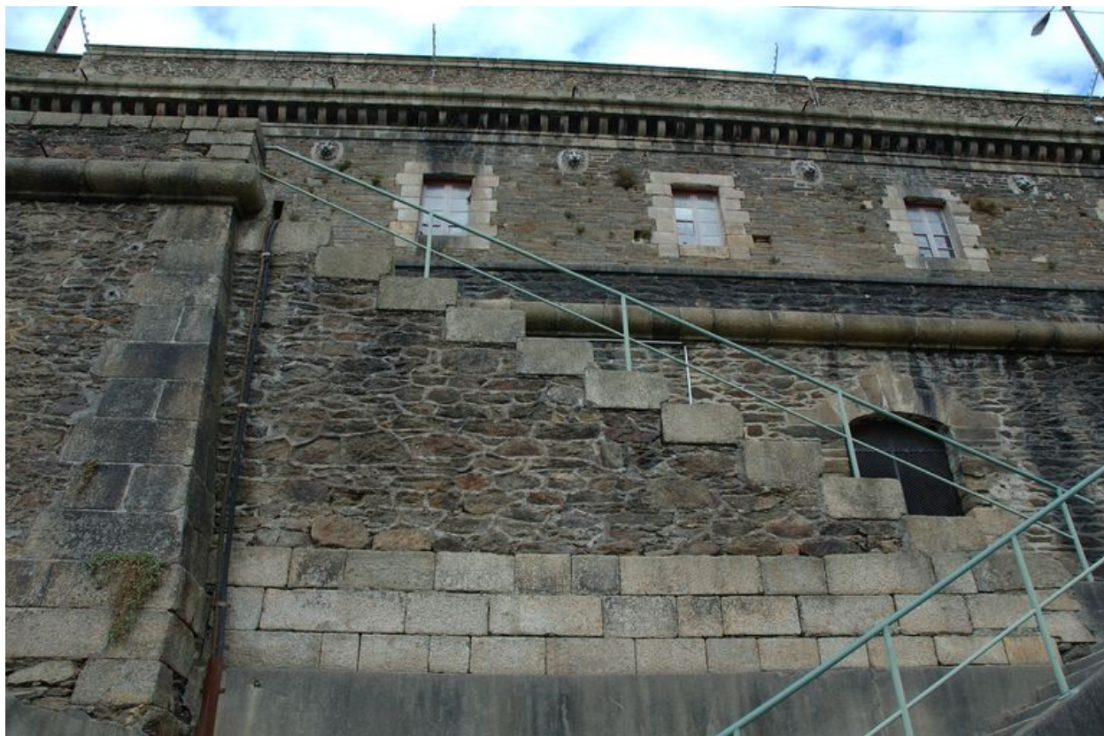
Vue de l'escalier d'accès aux latrines (soubassement en pierre de taille de granite)
