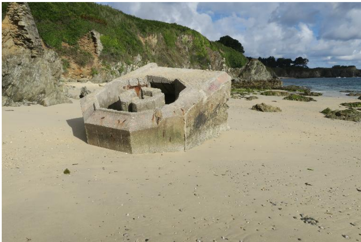
Locmaria, Grands Sables, extrémité ouest effondrée.
