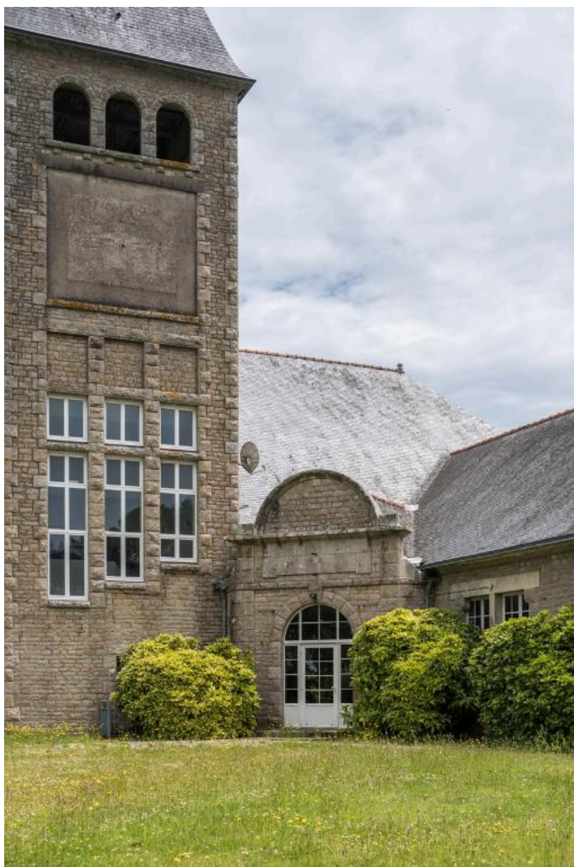
Vues de la croisée des ailes : entrée du hall principal et façade ouest du beffroi. Georges-Robert Lefort, architecte, 1929.
