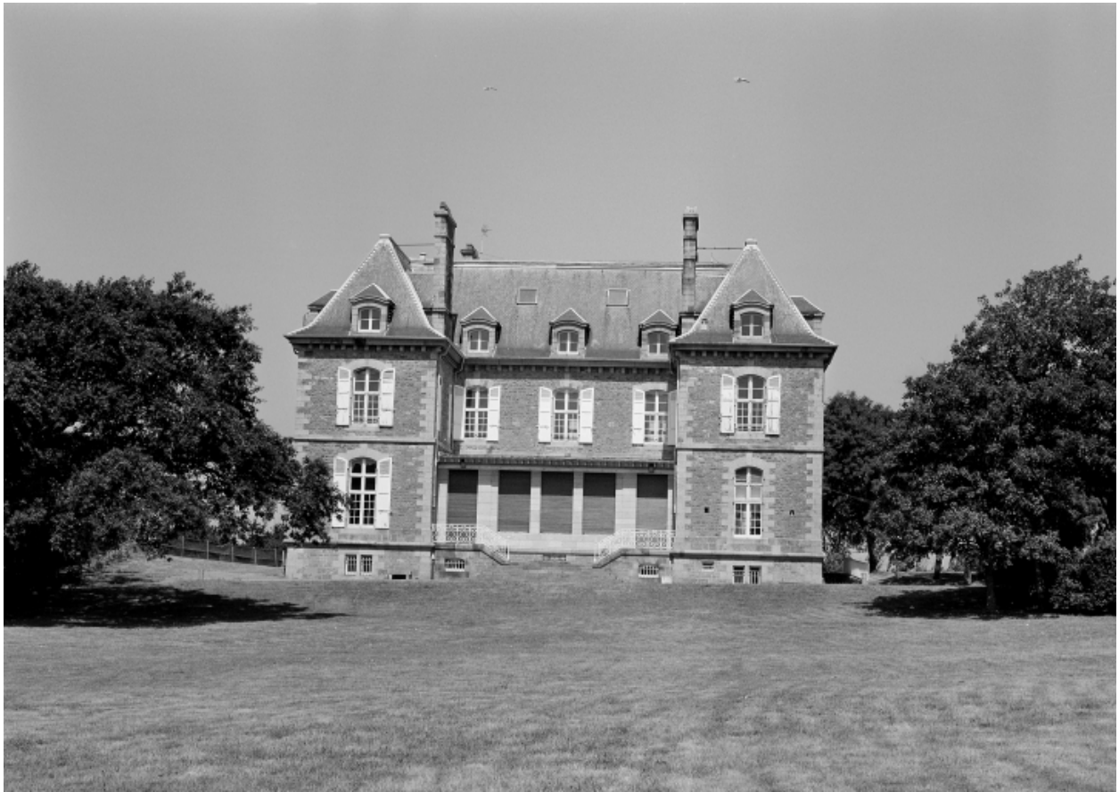
Vue générale de la façade sud-ouest sur jardin.
