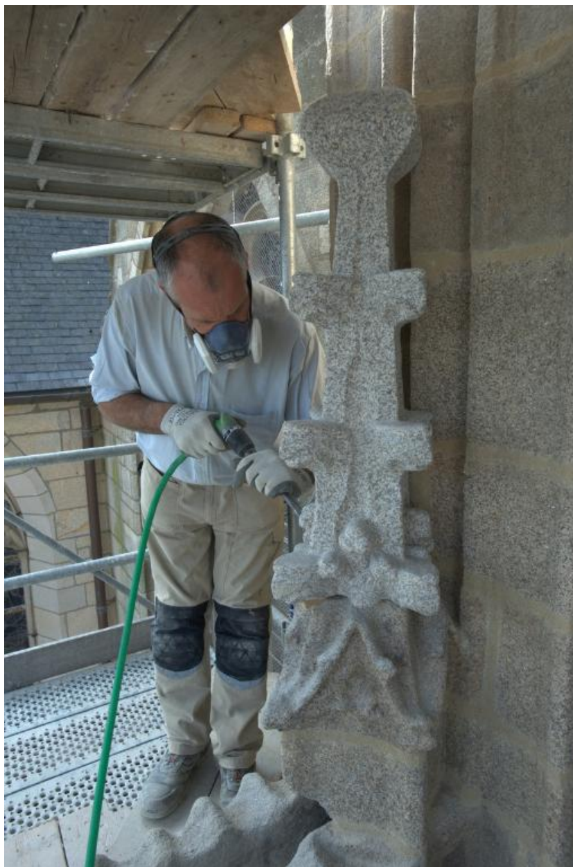
Portail nord, restauration d'un pinacle
