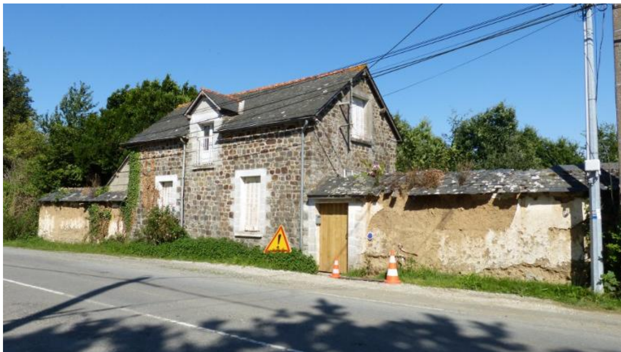
Vue générale, La Magdeleine (Hédé-Bazouges)
