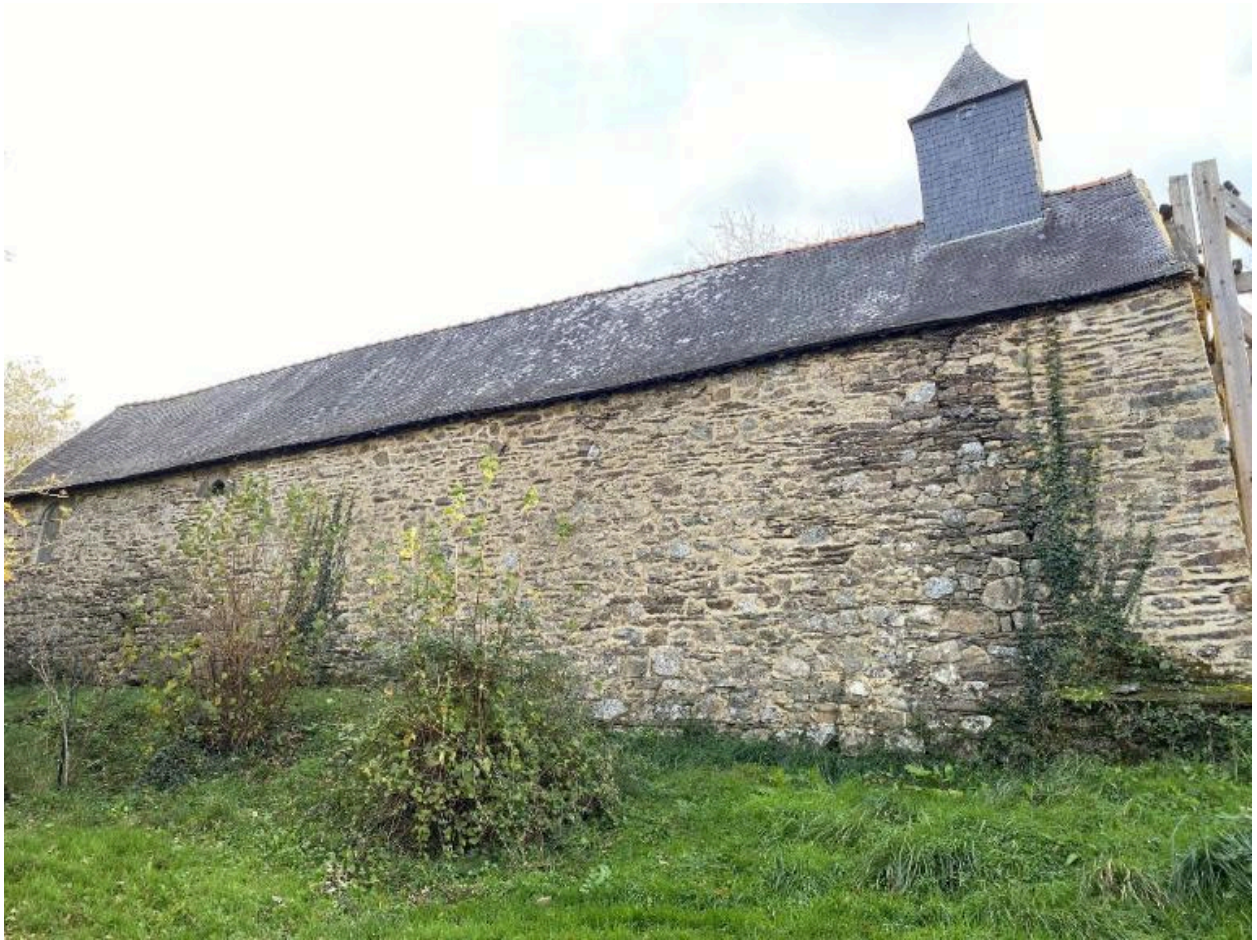
Vue générale nord
