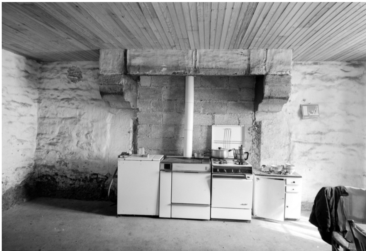
Vue de la cheminée de la pièce A du rez-de-chaussée
