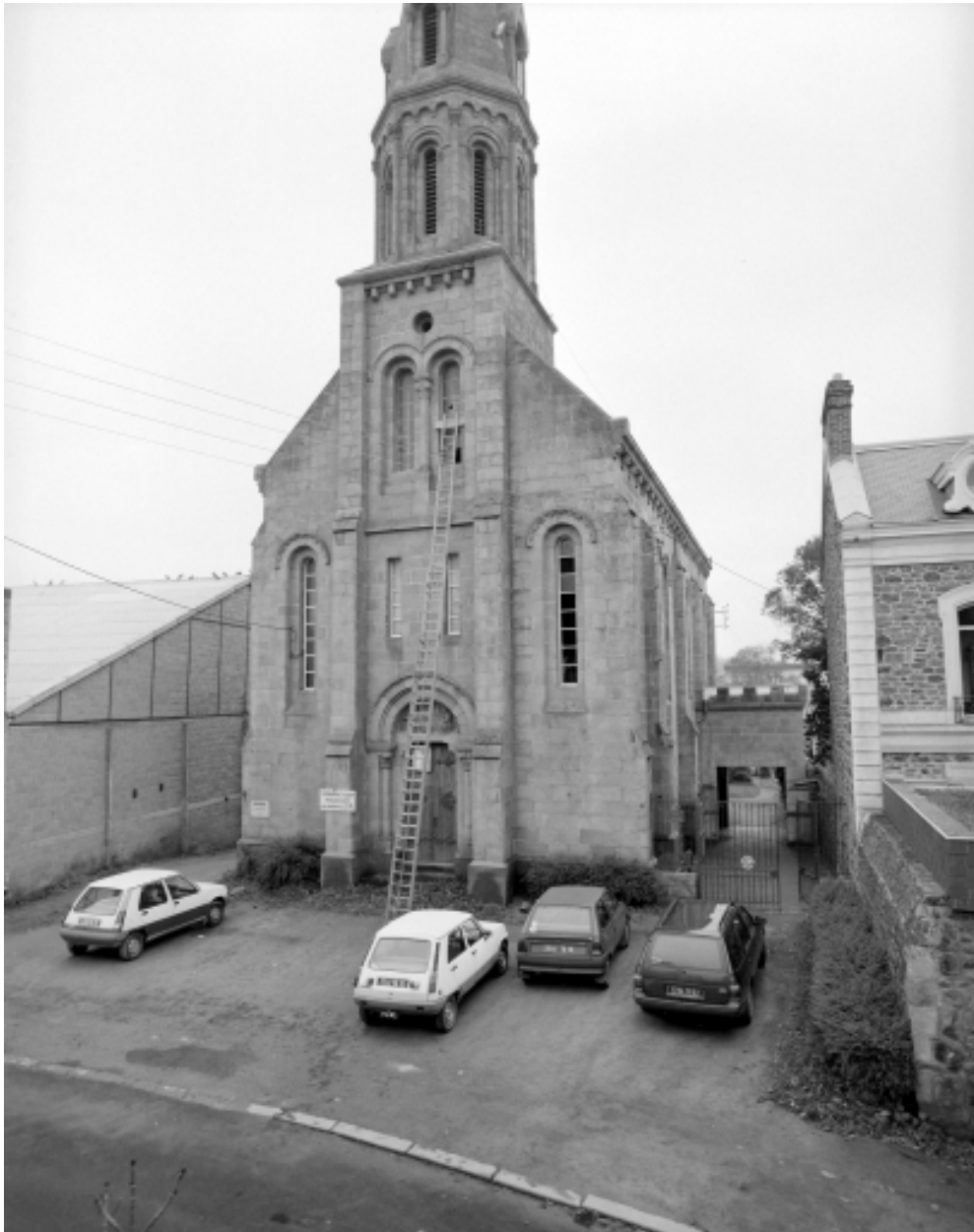
Elévation Ouest : vue générale
