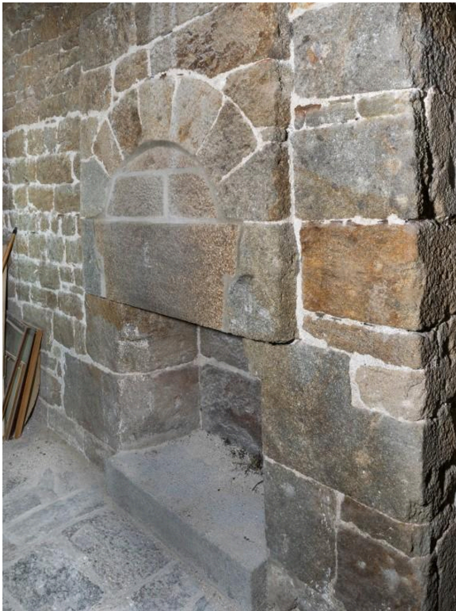
Vue intérieure de la tour Solidor : premier étage, corps de garde (tour nord et pièce située au-dessus du passage d'entrée), cheminée à piédroit chanfreiné
