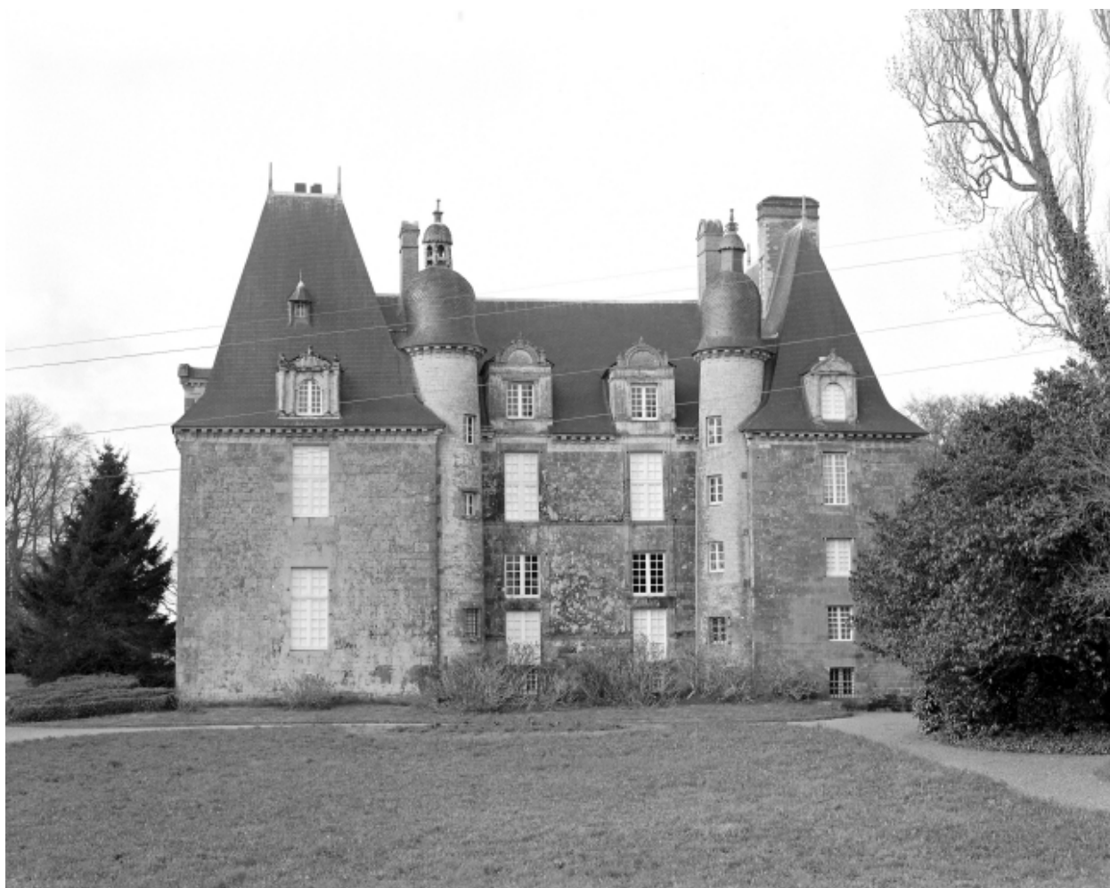
Elévation nord, vue frontale.
