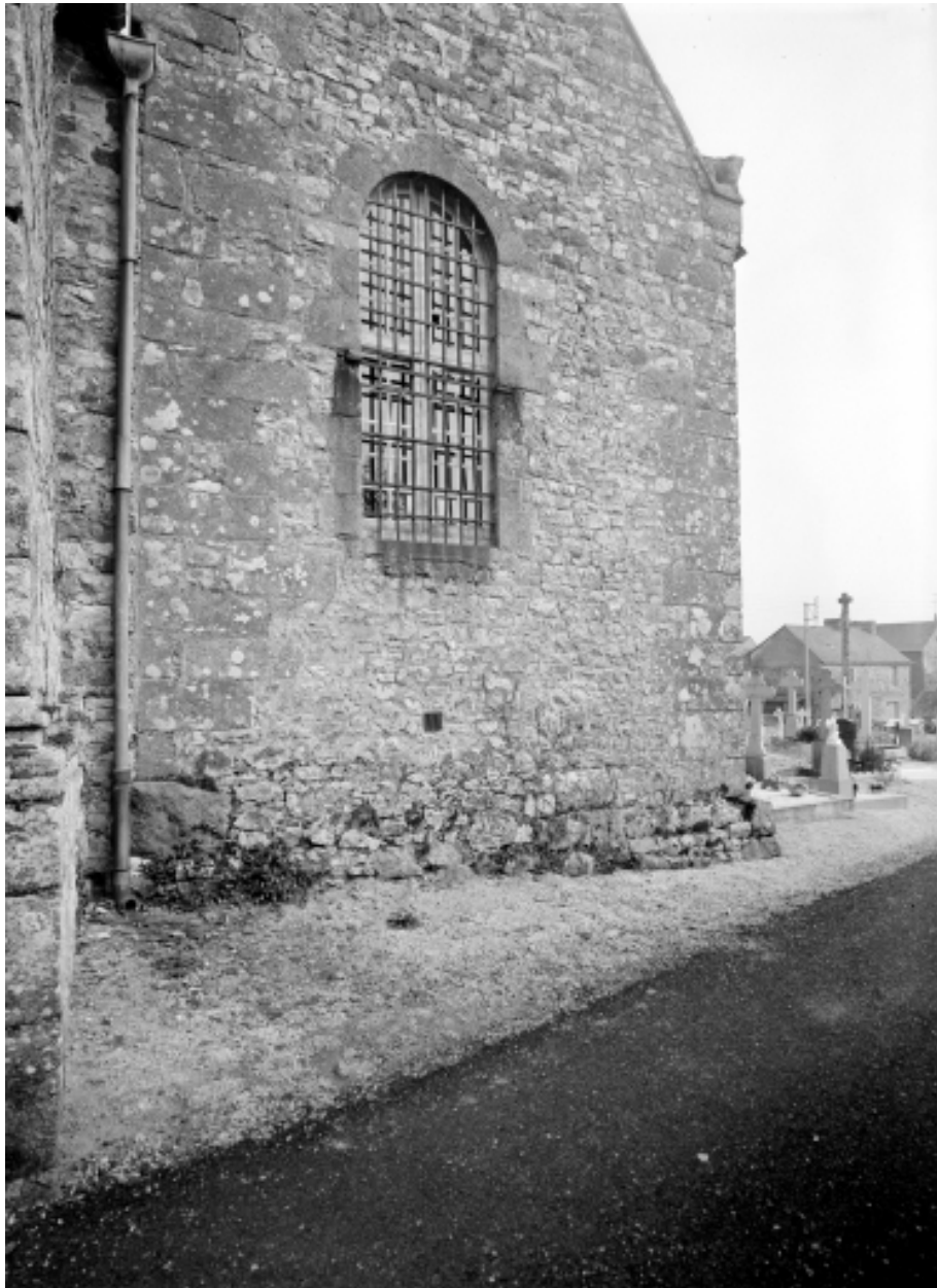
Elévation sud, sacristie, mur sud : vue générale
