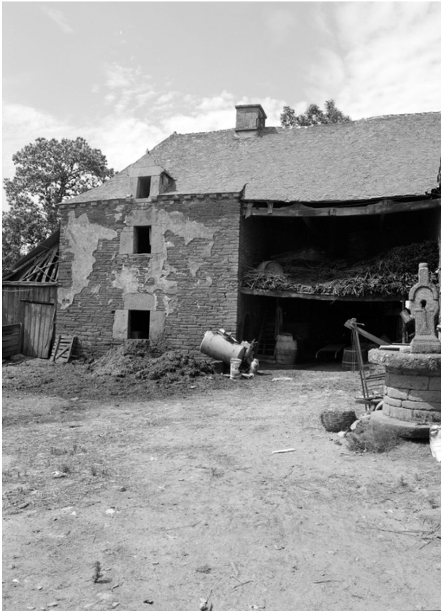
Vue générale sur la grange
