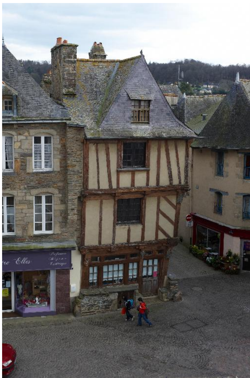
Elévation ouest (état en 2012)
