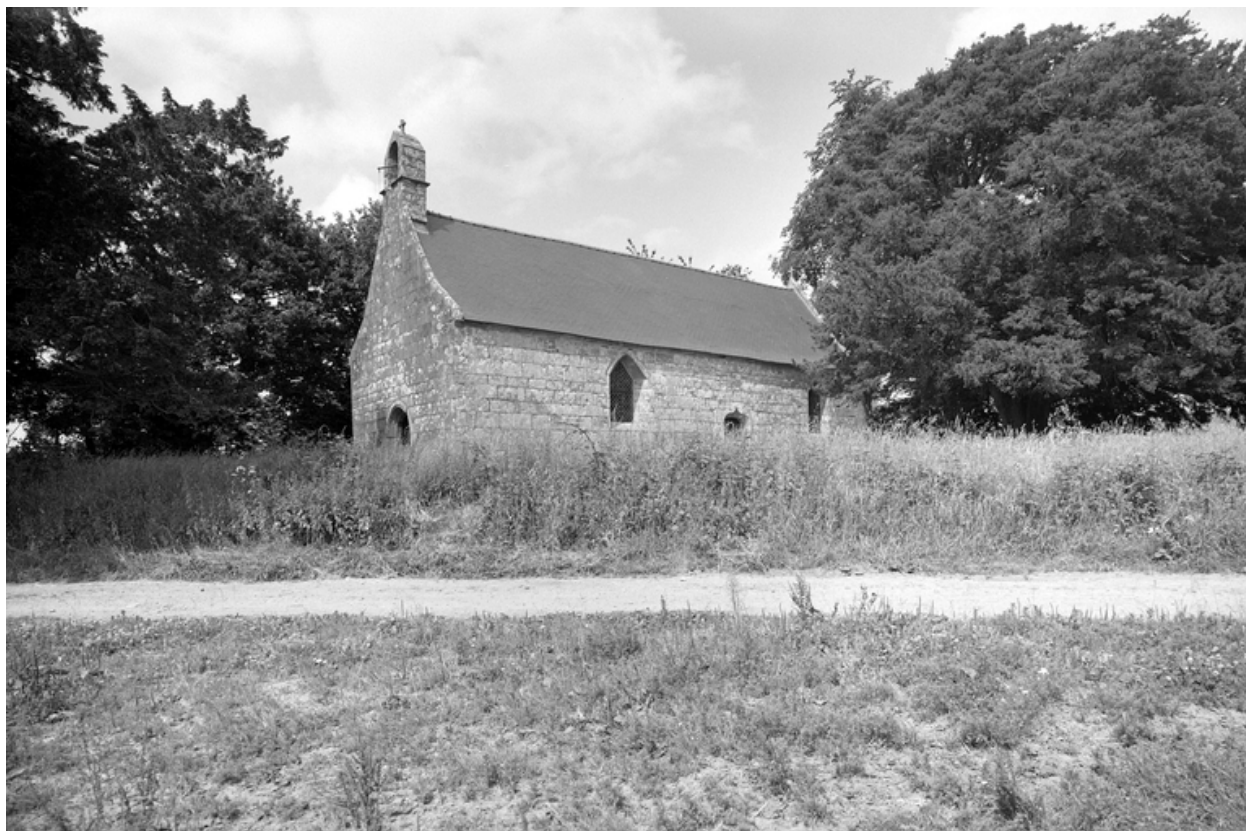
Vue de situation prise du sud ouest
