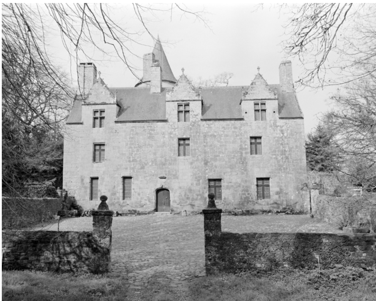
Logis, élévation antérieure : vue de situation.
