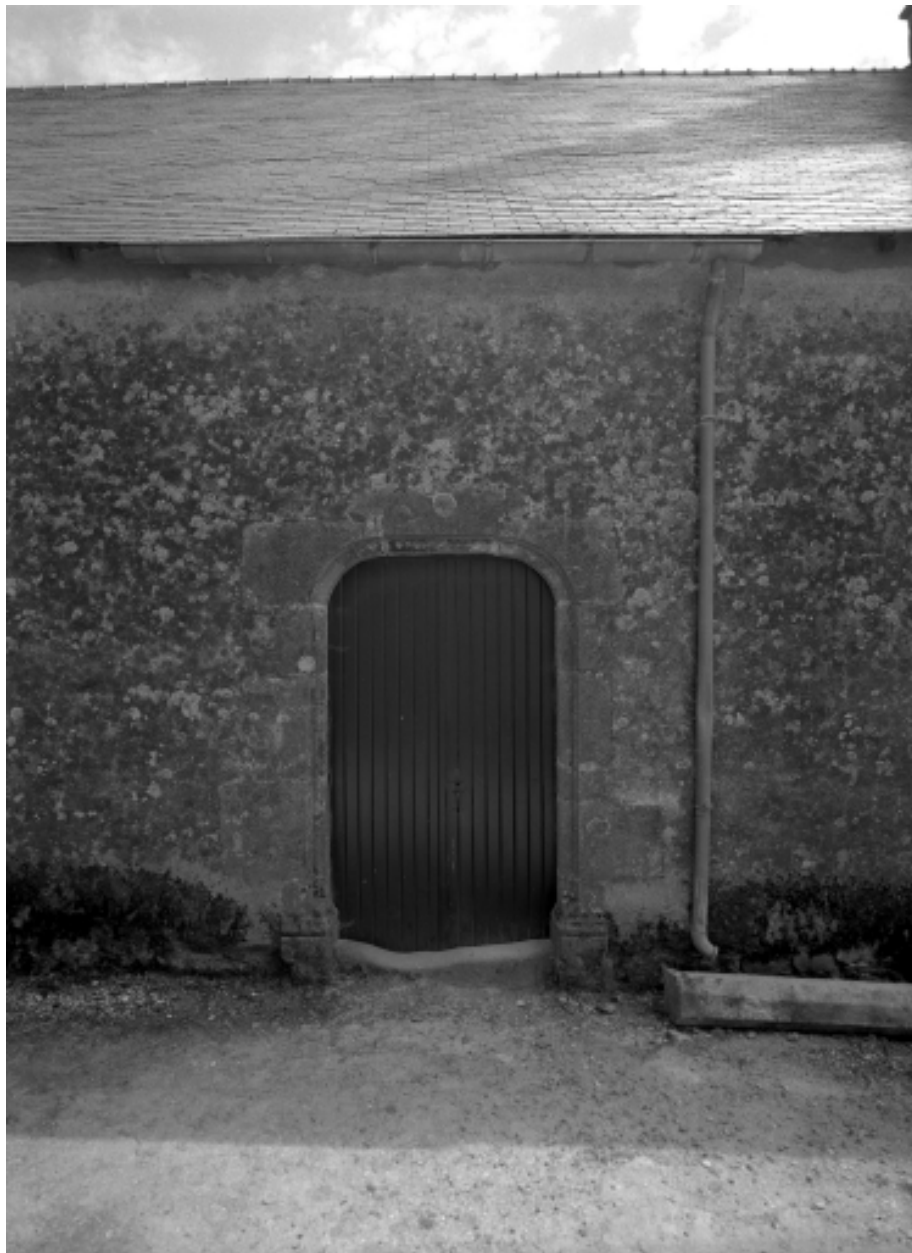
Plomodiern, église paroissiale Saint-Mahouarn : façade nord, porte du bas-côté, état en 1972
