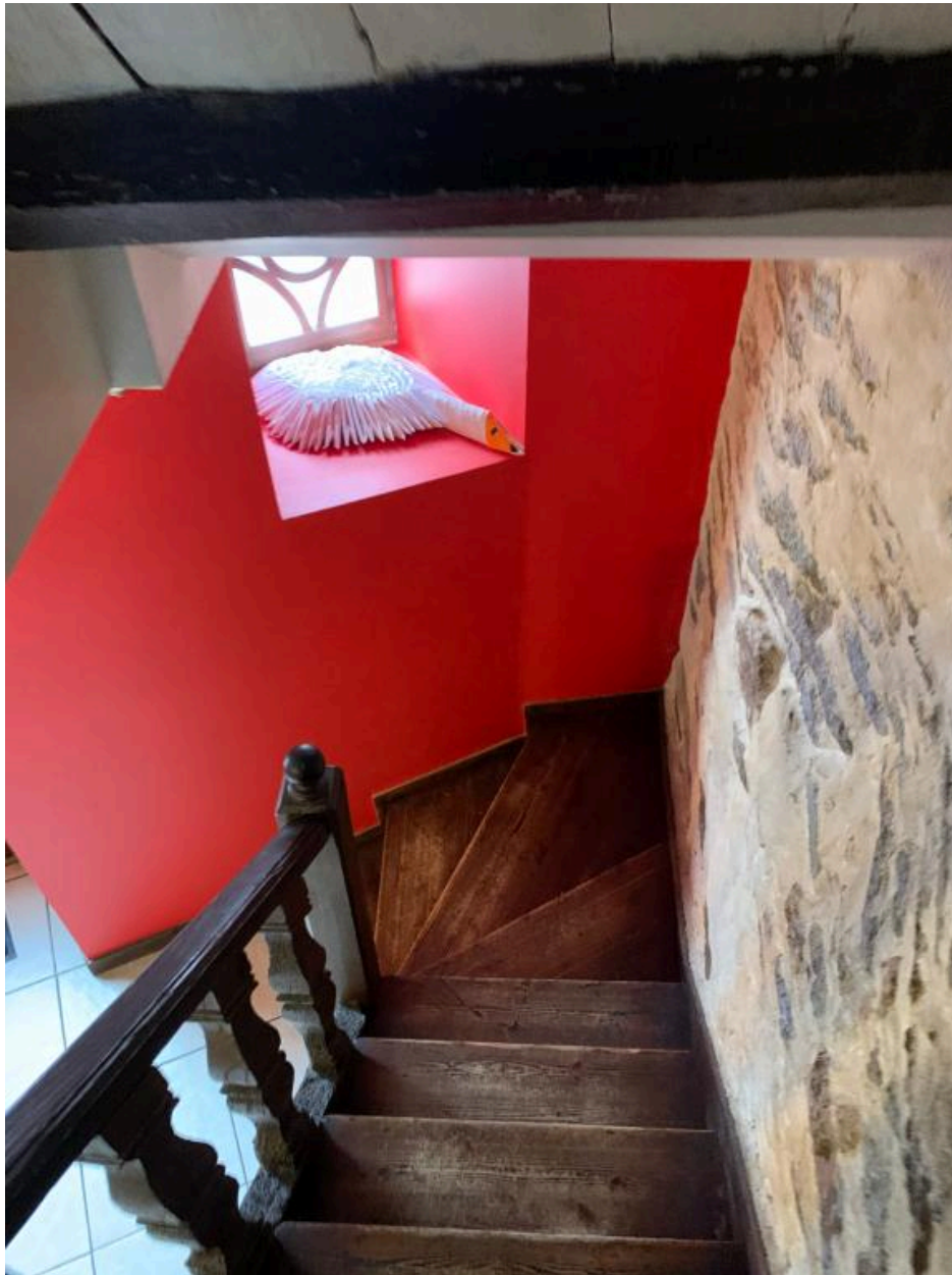
Partie ouest, premier étage, escalier
