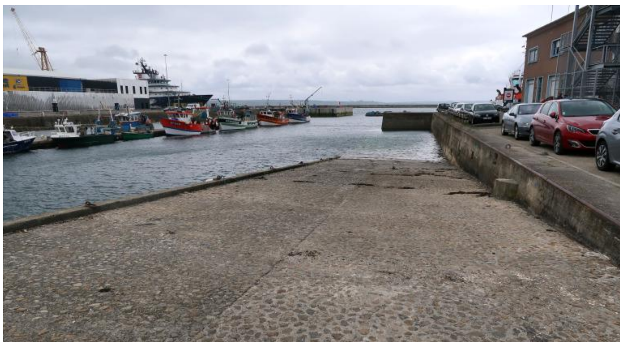
3e bassin, cale du quai Ouest
