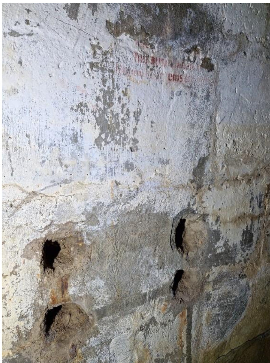
Vue intérieure : salle de garde ouest, emplacement du ventilateur et marquage en allemand
