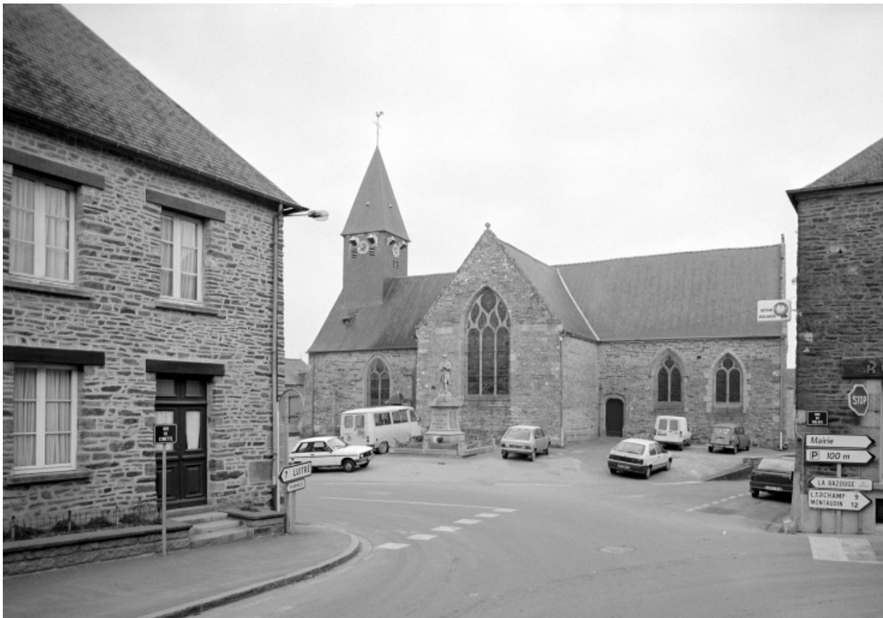
Élévation Sud : vue générale
