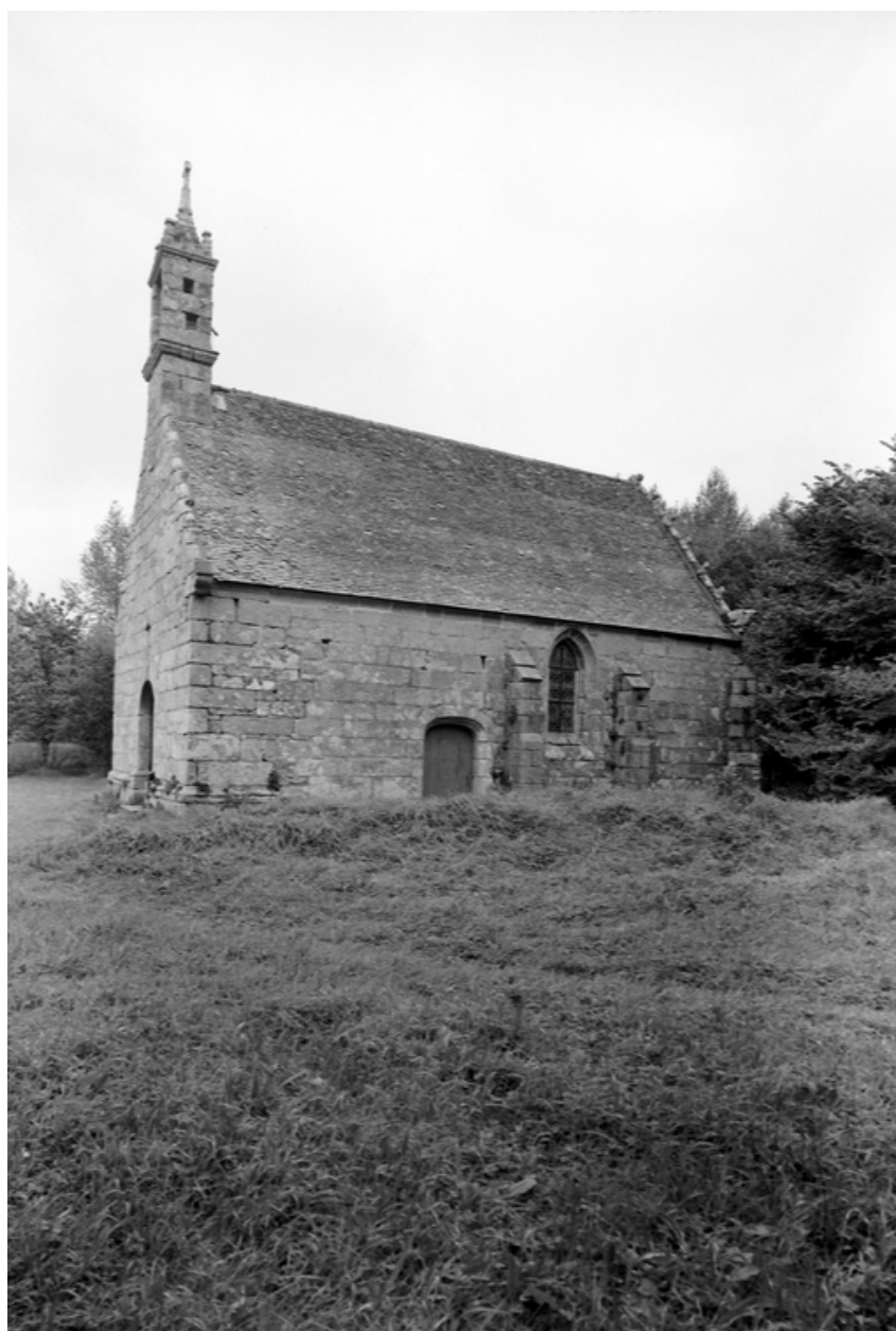
Vue générale de la face sud
