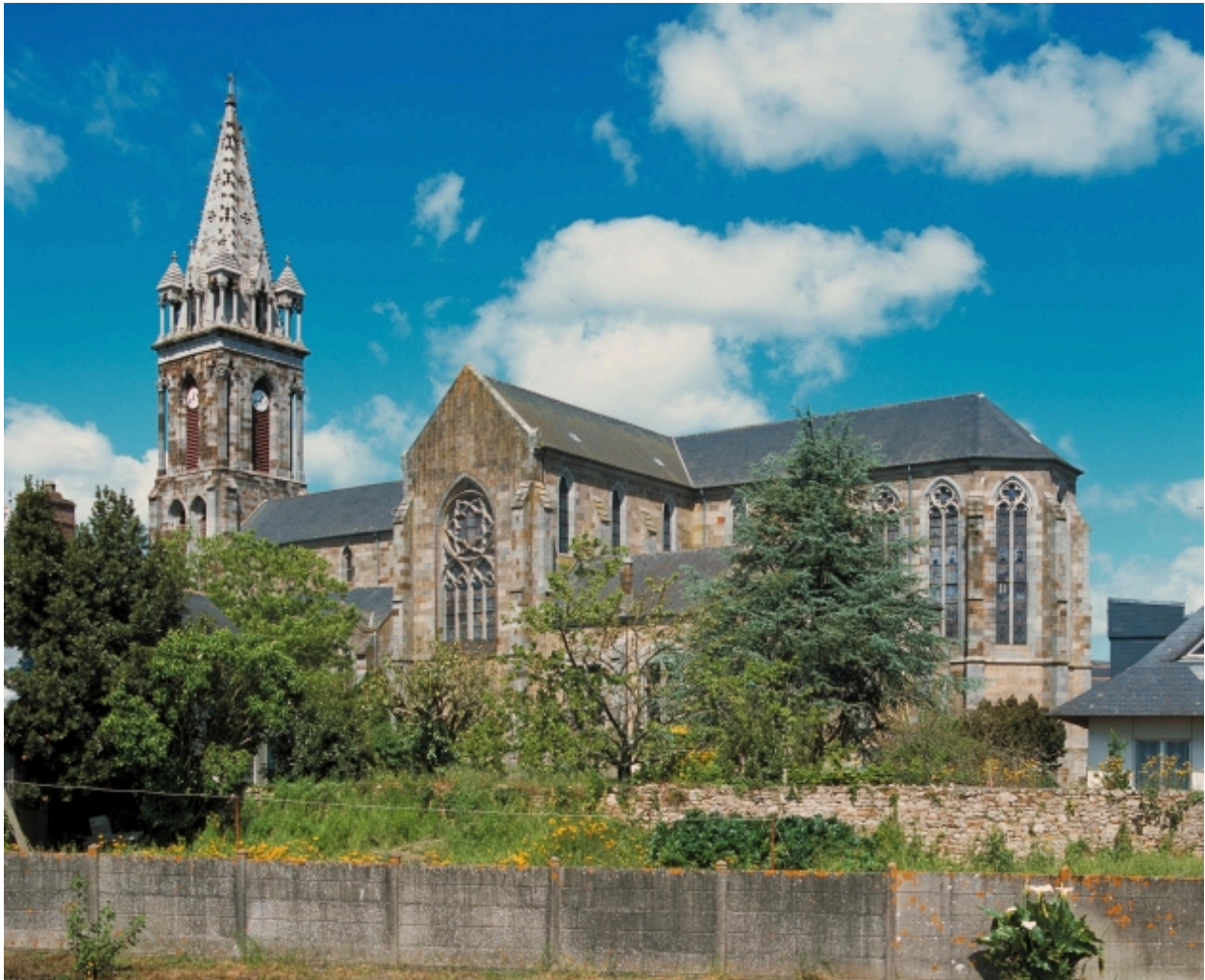
Elévation sud est ; vue générale
