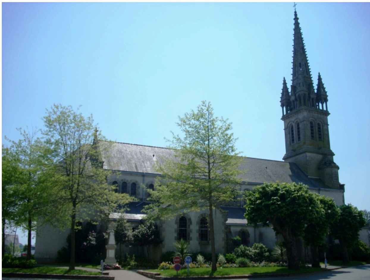
Plomelin, église paroissiale : vue générale nord-est
