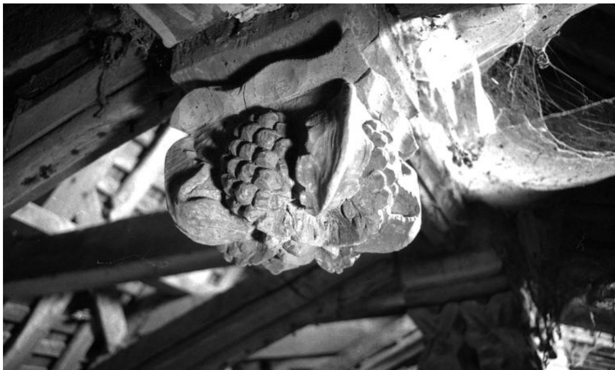
Charpente, détail de la clé 20.
