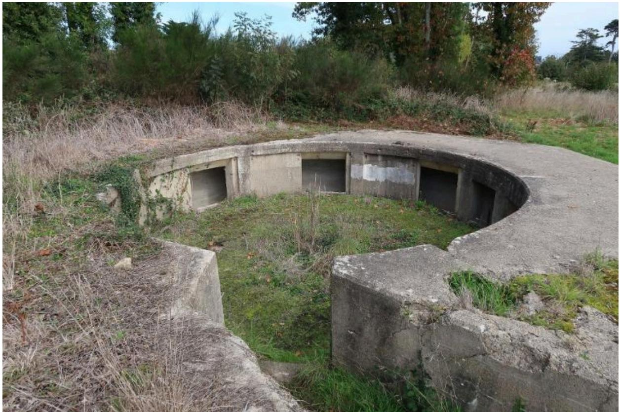
Vue du bunker-cuve de type Fl243a (V) pour canon antiaérien de 10.5 cm depuis le sud-ouest : au premier plan, l'entrée orientée vers le sud ; autour de la cuve circulaire sont implantées sept niches-abris pour les soldats et les munitions
