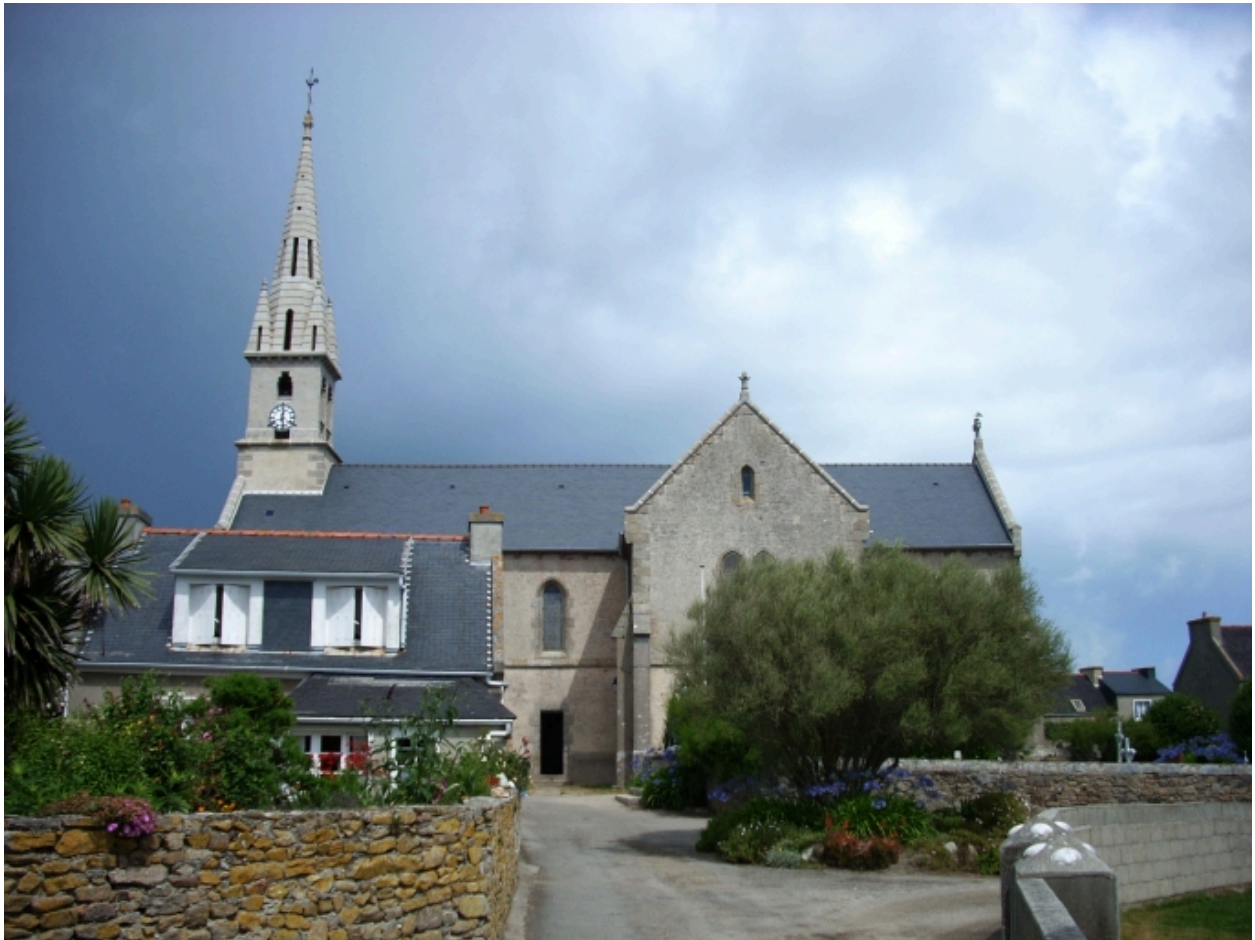
Ile-Molène, église paroissiale Saint-Ronan : élévation sud
