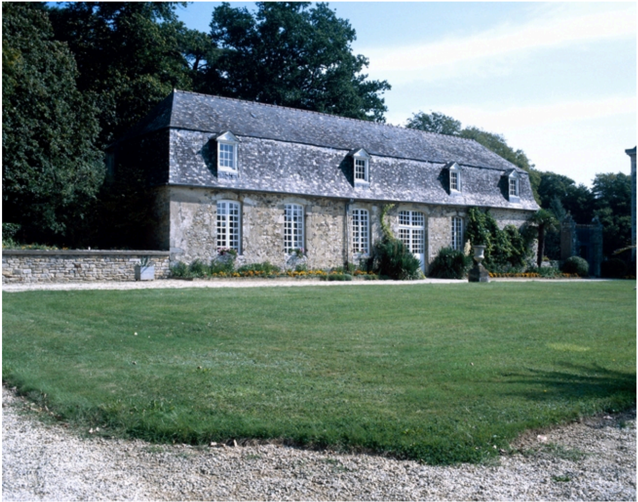
Orangerie, vue générale.
