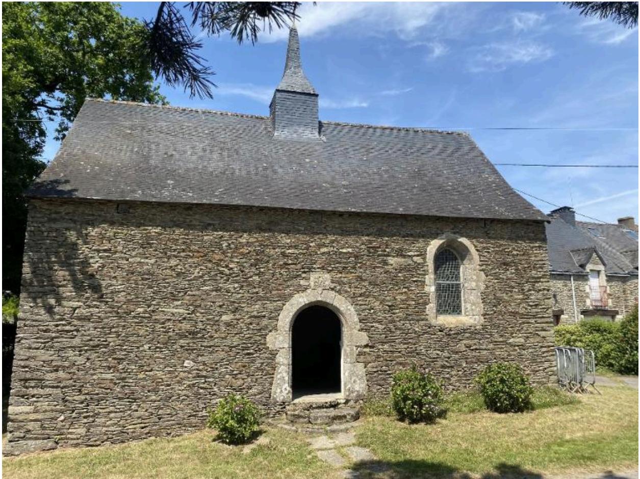
Élévation sud, vue générale
