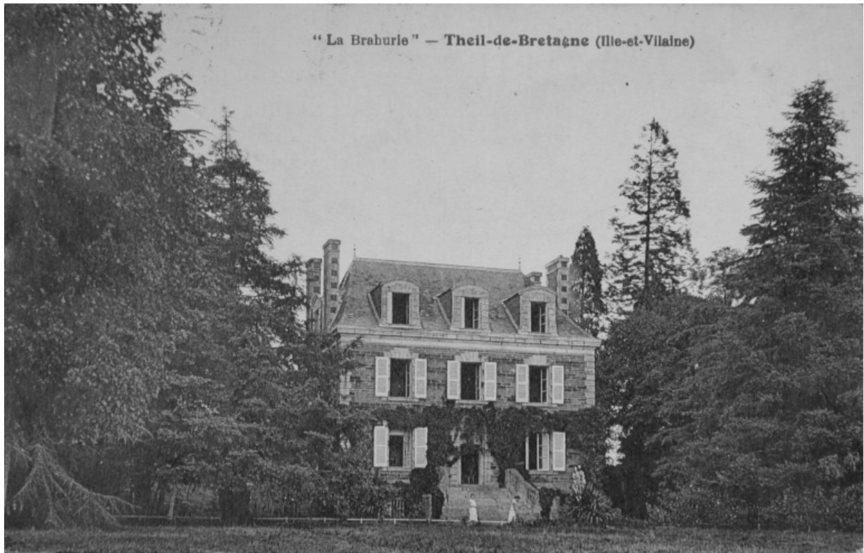
Vue générale au début du 20e siècle
