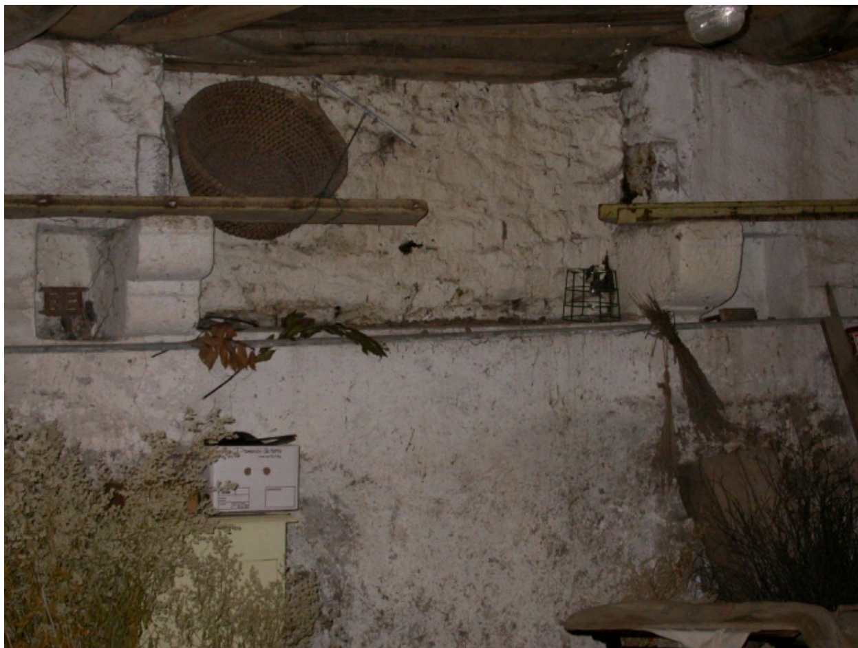
Vestiges de la cheminée de l'ancien logis
