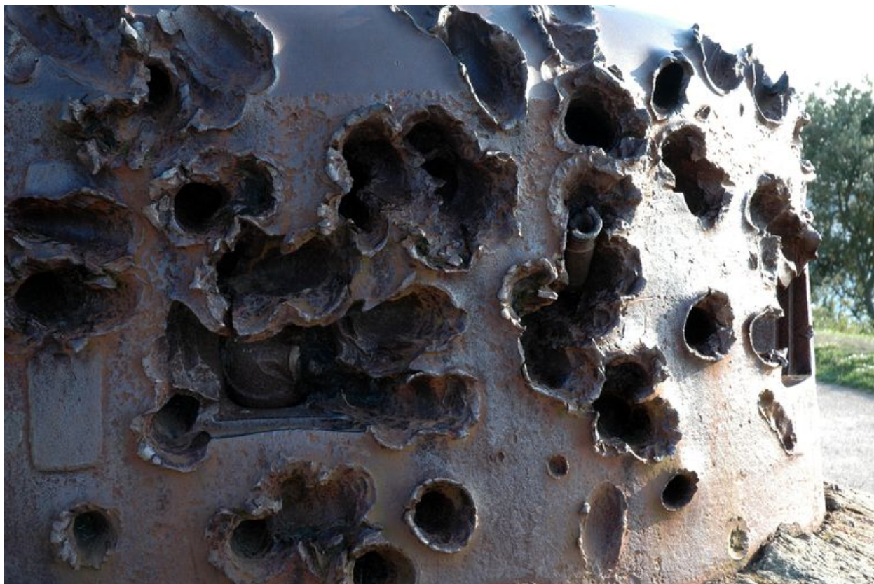
Cloche blindée pour mitrailleuse implantée sur un bunker : effets des combats d'août 1944
