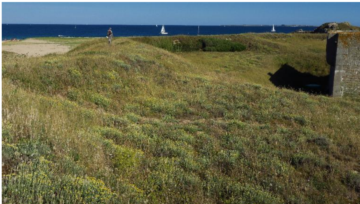
Île-d'Houat, batterie d'En Tal, terre-plein et parapet.
