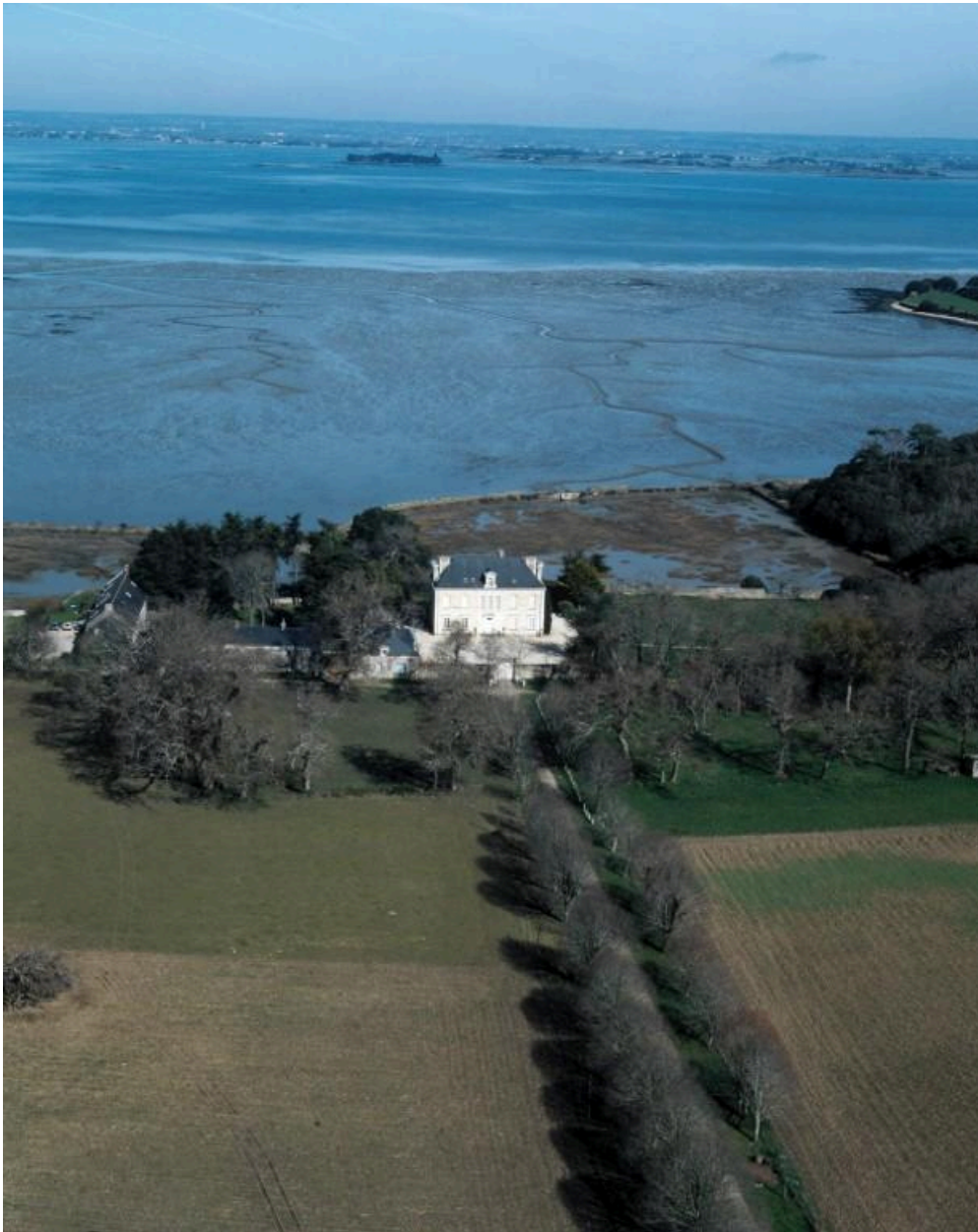
Vue aérienne sud.
