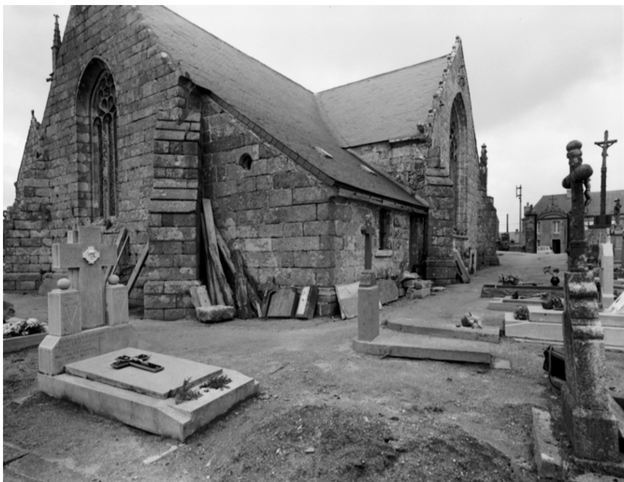
Sacristie : vue nord-est
