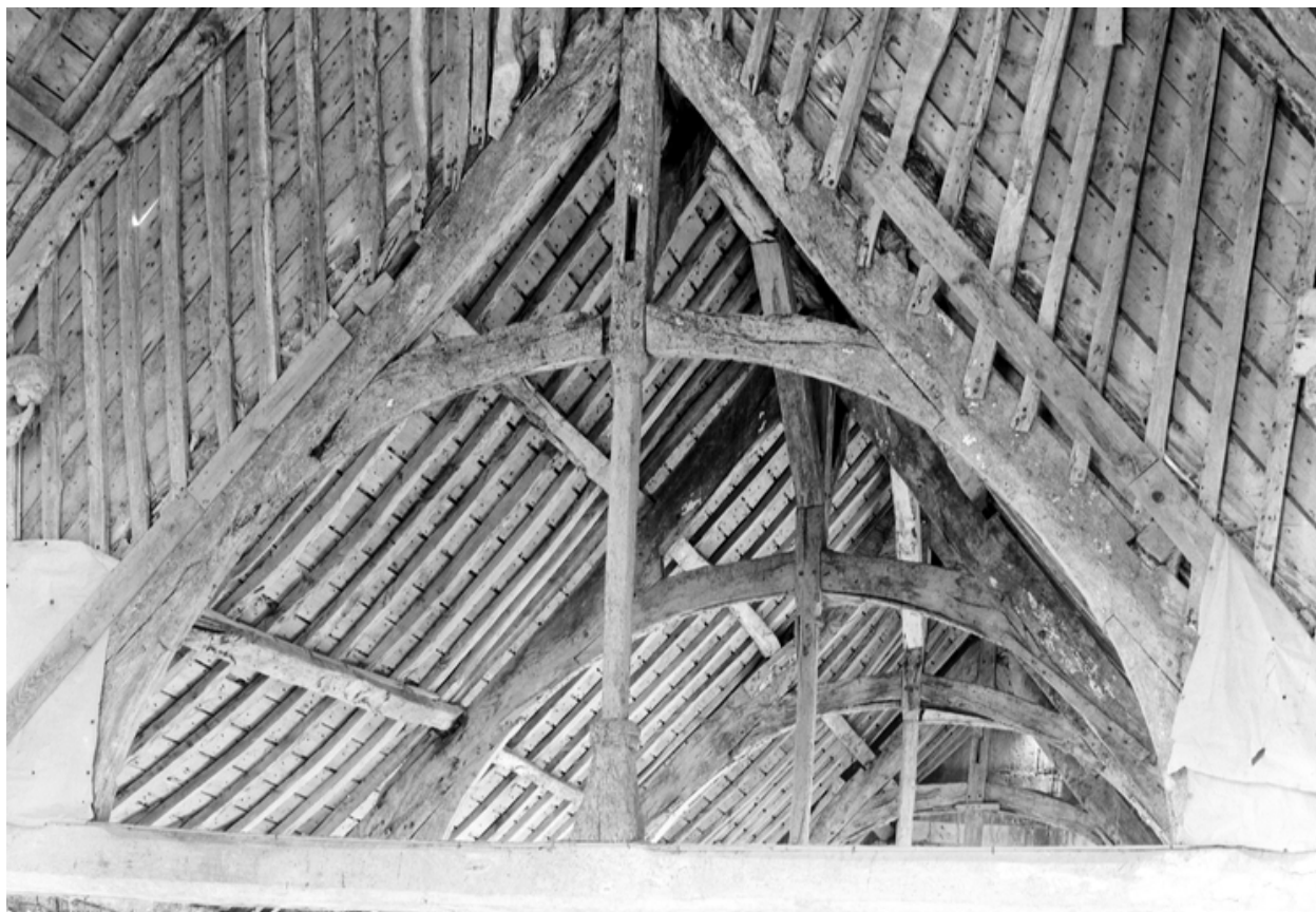
Détail de la charpente
